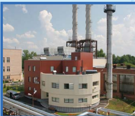
Газотурбинная электростанция мощностью 6 МВт
