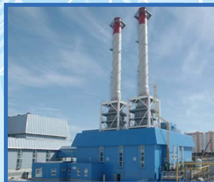
Газотурбинная электростанция мощностью 10 МВт
